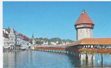
4 die Kapellbrücke, Luzern (CH)
