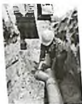
Quvurga polivinilxlorid truba yotqizilishi (o'rtada)
