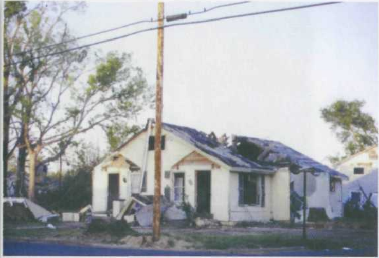
Илл. 64. Американский жилой дом, разрушенный торнадо.
